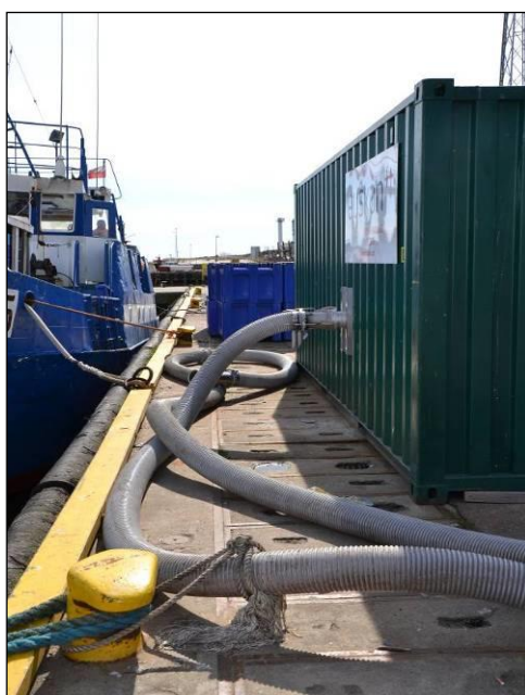
Fot. 8. Przewody rurowe do hydraulicznego wyladunku ryb z kutrów rybackich rybackich (fot. MIR-PIB)
